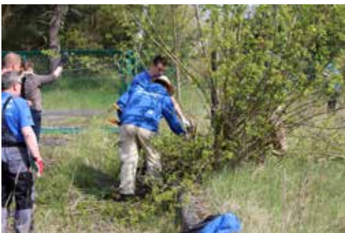
Der Zaun ist freigelegt, jetzt geht es weiter mit Sichtschneisen
