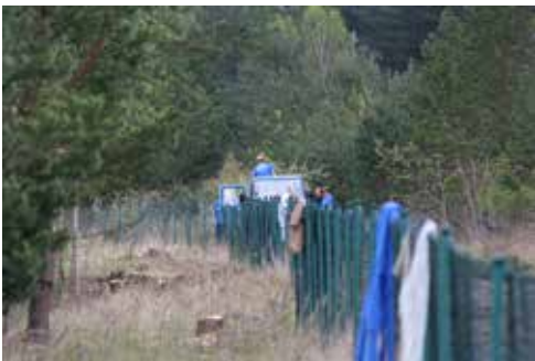
Gut zu erkennen ist die entstandene Schneise
