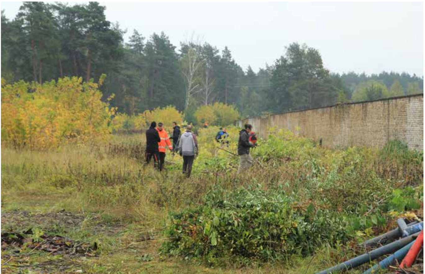
Bäume wurden entfernt und die Lagermauer sichtbar
